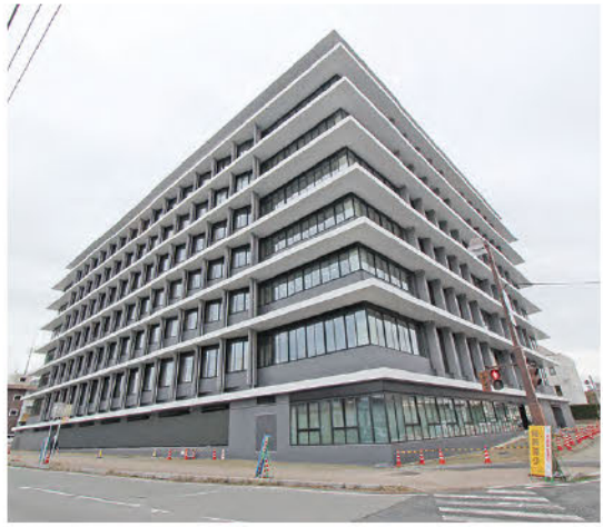
5月に供用開始される山口市役所本庁舎
